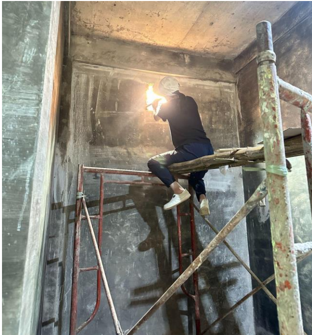
要先打穿牆壁才能安置電扇
